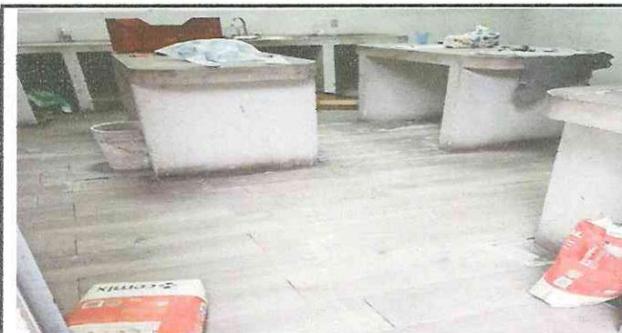
Foto 6: COLOCACION DE PISO EN LA COCINA.
