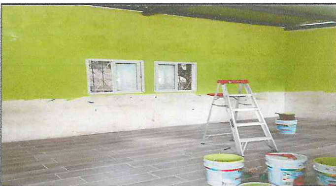
Foto 4: COLOCACION DE PISO Y PINTURA EN EL AULA DE 5TO PRIMARIA
