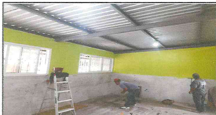
Foto 3: COLACION DE PISO Y PINTURA EN EL AULA DE 6TO. PRIMARIA
