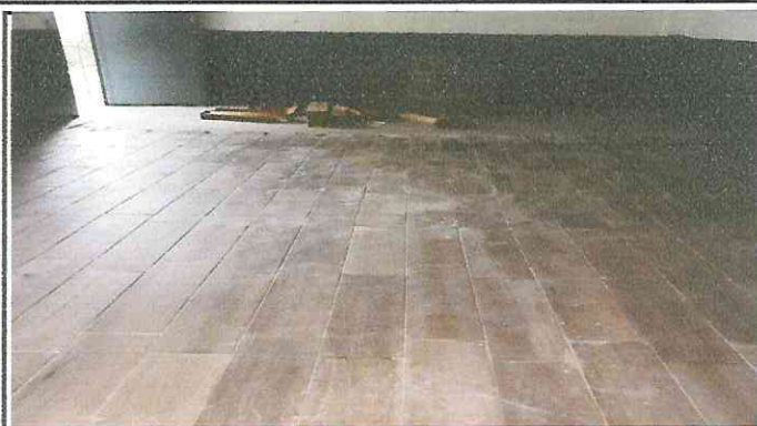
Foto 2: COLOCACION DE PISO EN EL AULA DE 2DO. SECCION B
